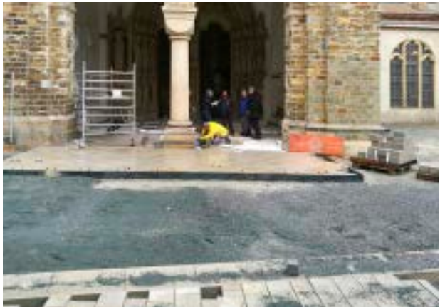
Abb. 9 Verlegen des übergreifenden Pflasters im Bereich Paradiesportal
