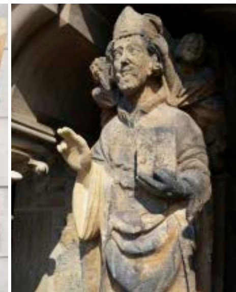
Erneuerung der segnenden Hand an der Figur Bischofs Simon zur Lippe Im Bild links ist auf der rechten Seite der Rohling für die Kopie zu erkennen.
