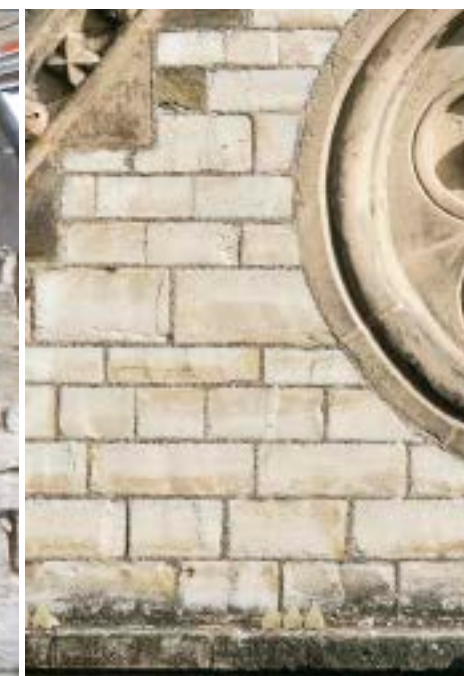
Sanierung schadhafter Bereiche des Mauerwerks
