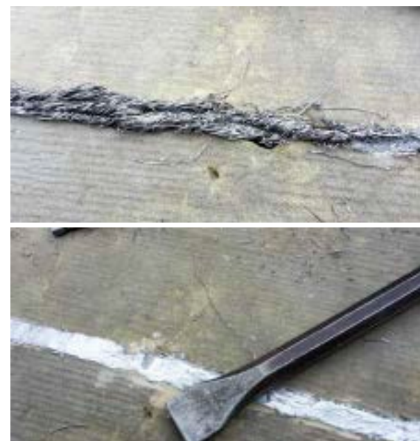
Fugenabdichtung mit Bleiwolle
