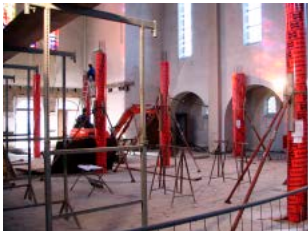
Aufbau der Trägersäulen für die neuen Geschosse
