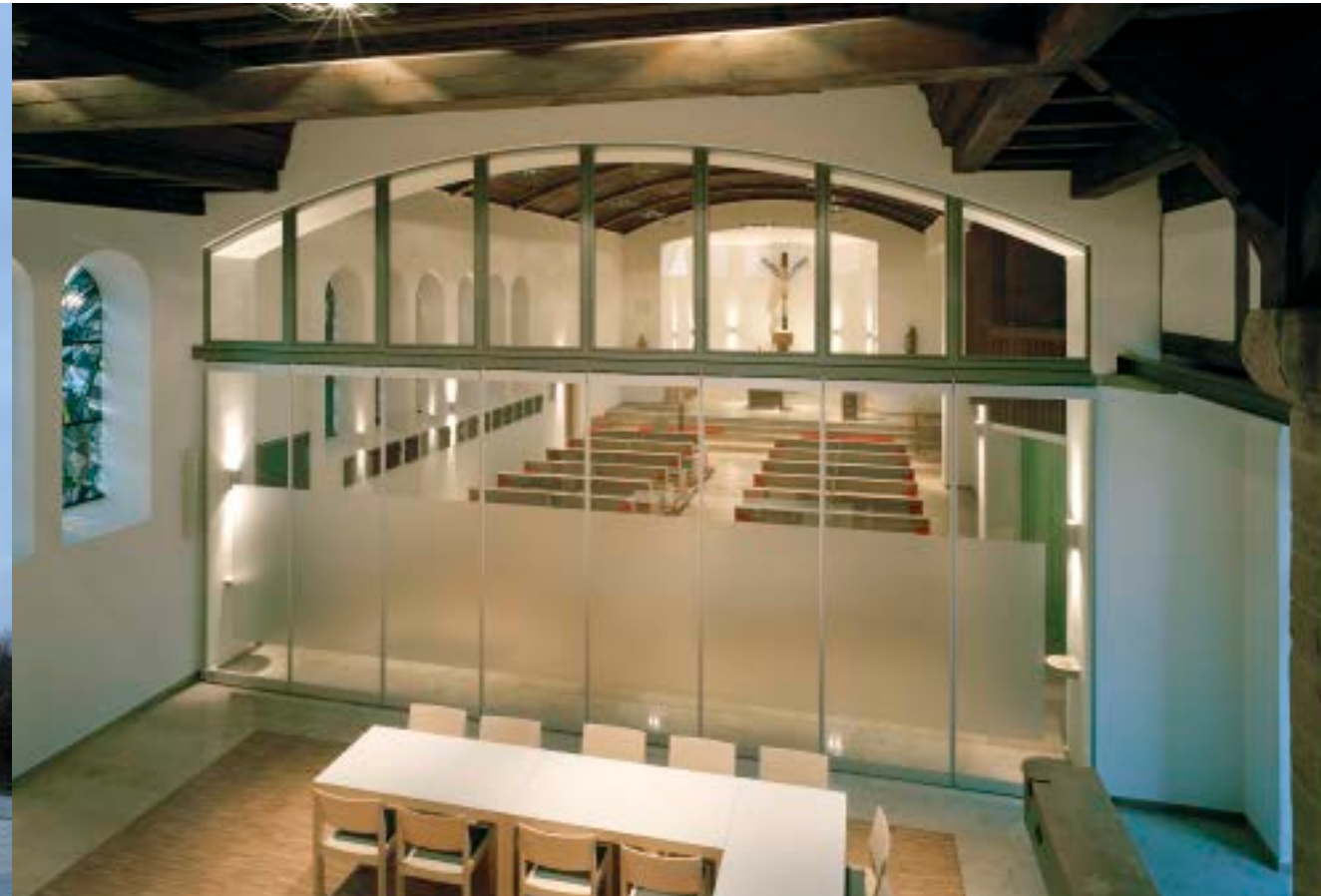
Die Glastrennwand in Funktion: Der abgetrennte Raum kann als Pfarrsaal genutzt werden.
